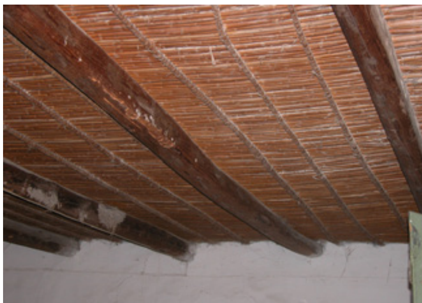
Fig. 3.53. Solaio ad orditura semplice con incanniccio e canne maestre.
