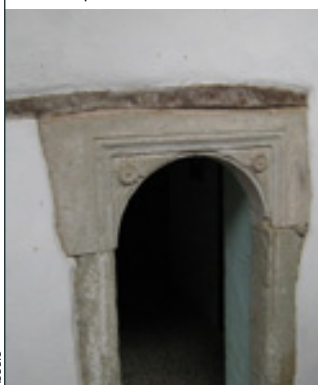
A_b 5 Porta con architrave monolitico e intradosso sagomato ad arco a tutto sesto, con stipiti monolitici
