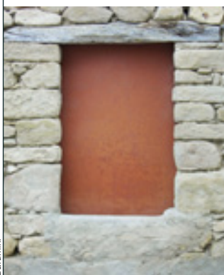
A_a 5 Finestra con architrave ligneo e stipiti in mattoni crudi
