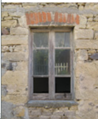
B_a 8 Finestra con arco ribassato in mattoni cotti e stipiti in conci lapidei sbazzati o mattoni cotti
