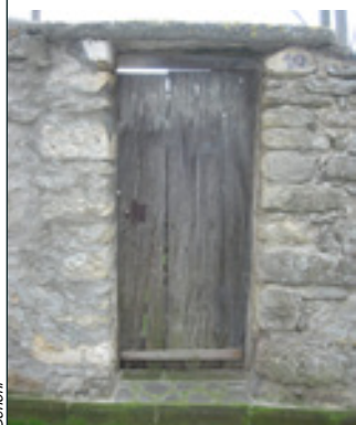
A_b 4 Porta con architrave monolitico e stipiti in conci squadati, con cornice a rilievo
