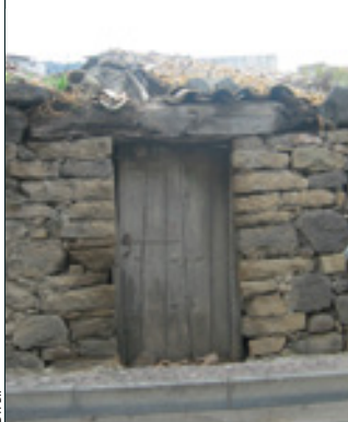
A_a 2 Porta con architrave ligneo e stipiti in conci lapidei sbozzati o squadati
