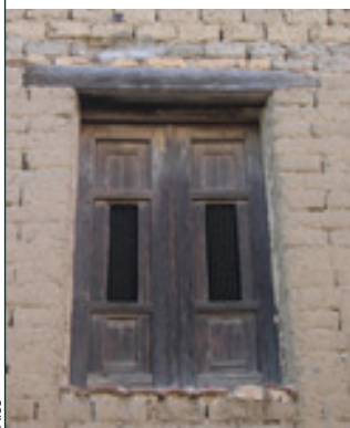
A_b 2 Finestra con architrave monolitico e stipiti in conci ammortati alla muratura
