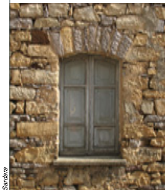
B_b 1 Finestra con arco a tutto sesto e stipiti in conci squadri o blocchi monolitici
