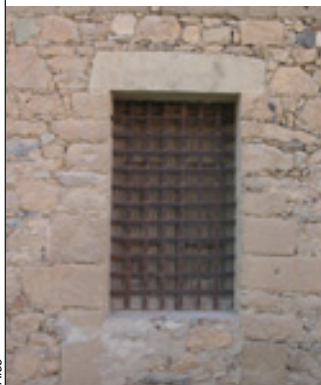
A_b 4 Finestra con architrave e stipiti monolitici con cornice squadrata a rilievo
