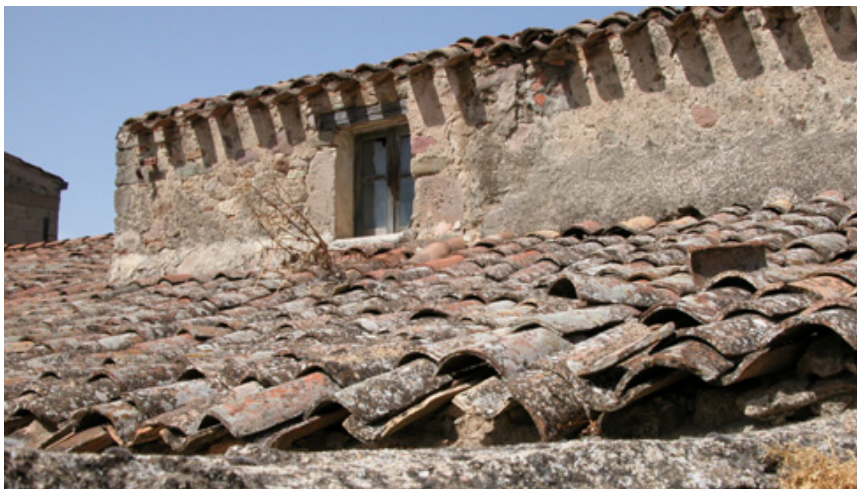
Fig. 3.36. Copertura in coppi sardi, Nureci
