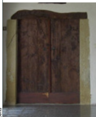
A_a 3 Porta con architrave ligneo e stipiti monolitici
