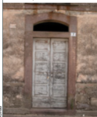
A_b 6 Porta con stipiti e architrave monolitici, con lunetta sopra luce e architrave superiore con profilo ad arco ribassato
