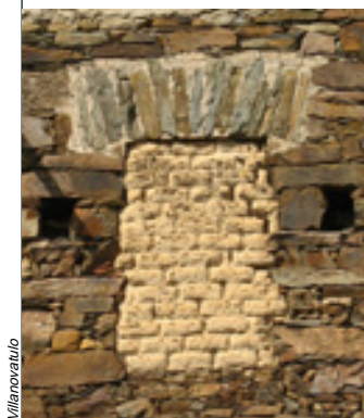
B_a 7 Finestra con arco ribassato in conci lapidei sbazzati e stipiti in conci lapidei con o senza ammoramento alla muratura
