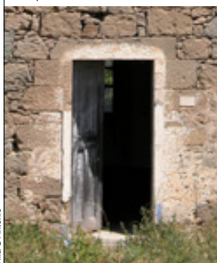
A_b 5 Porta con architrave monolitico e intradosso sagomato ad arco a tutto sesto, con stipiti monolitici
