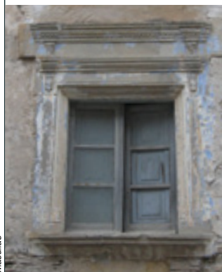
A_b 6 Finestra con stipiti e orizzontamenti in conci lapidei squadati non ammortati alla muratura, con decorazioni in rilievo
