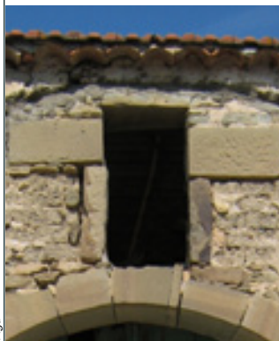
A_b 5 Finestra con architrave monolitico con intradosso sagomato ad arco ribassato e stipiti monolitici squadati
