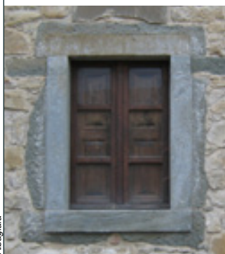
A_b 4 Finestra con architrave e stipiti monolitici con cornice squadrata a rilievo
