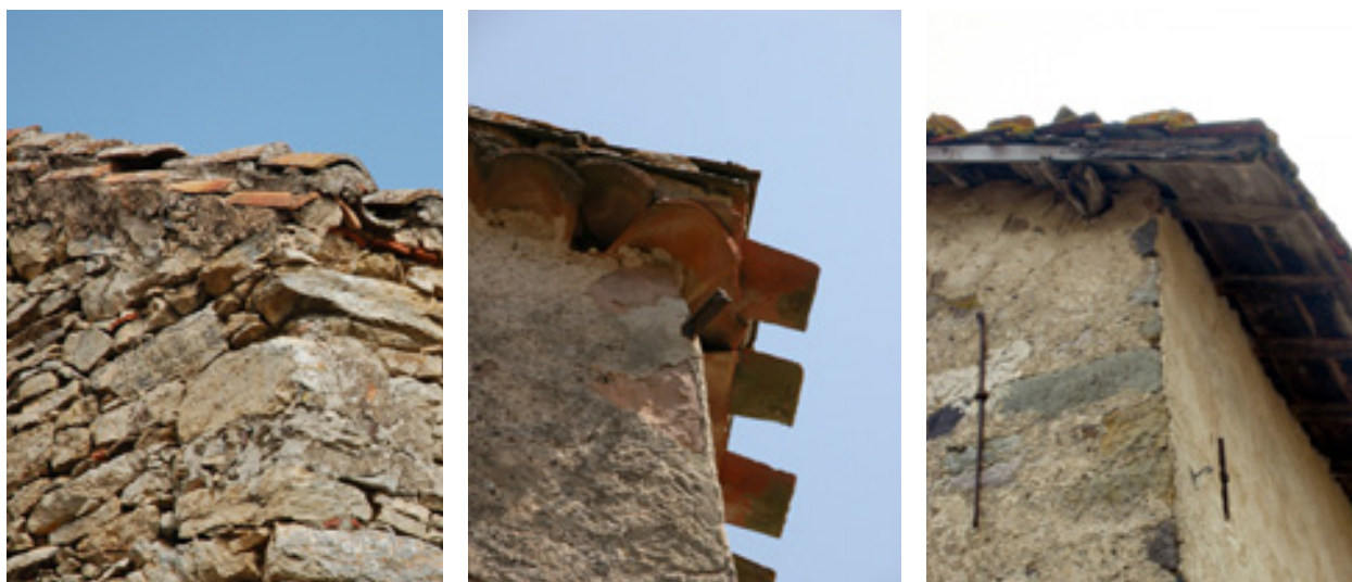
Figg. 3.42, 3.43, 3.44. Soluzioni di gronda, laterale.
