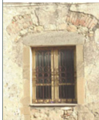
B_a 6 Finestra con piattabanda e stipiti in mattoni cotti
