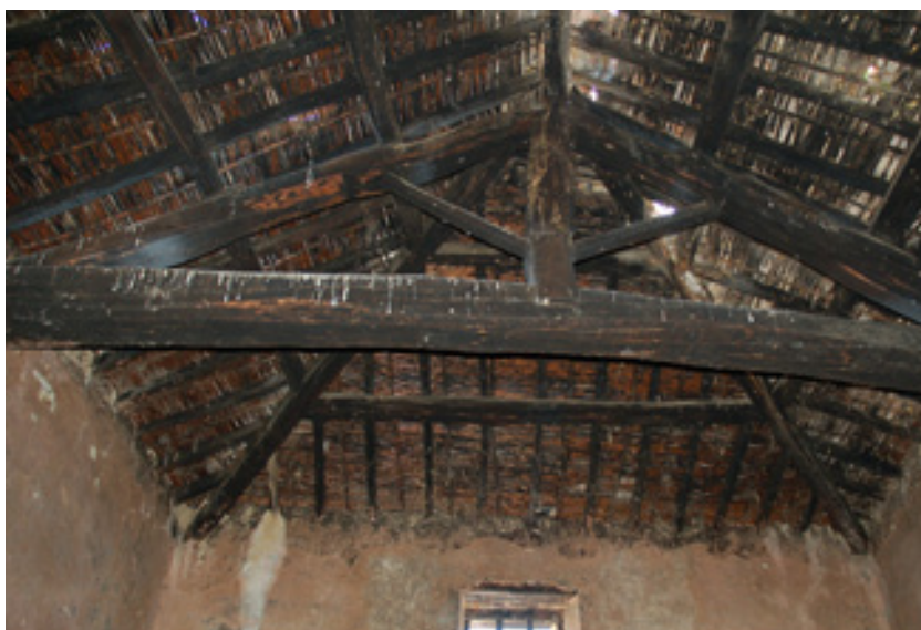
Fig. 3.25. Simala. Soluzione a padiglione con capriata.
