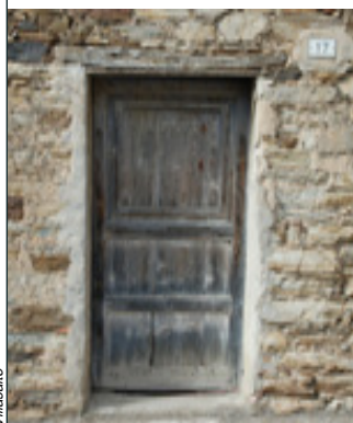
A_a 4 Porta con architrave ligneo e stipiti in mattoni crudi
