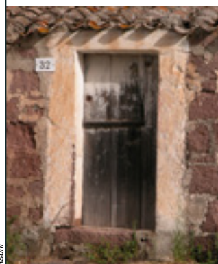
A_b 6 Porta con stipiti e architrave monolitici, con lunetta sopra luce e architrave superiore con profilo ad arco ribassato
