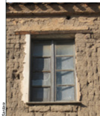
B_a 4 Finestra con piattabanda in conci lapidei e stipiti in conci lapidei sbazzati
