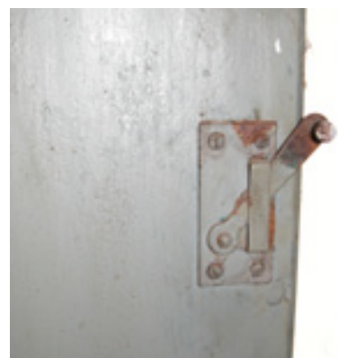
Figg. 3.62, 3.63, 3.64. Infisso di finestra, interno e particolari serramenta scuretti
