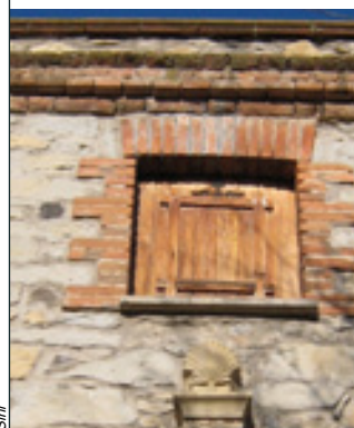
B_a 9 Finestra con arco a sesto ribassato e stipiti in mattoni cotti
