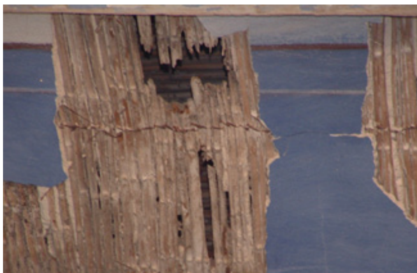
Fig. 3.54. Dettaglio del controssaffitto in canne con intradosso intonacato e affrescato
