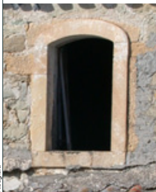
A_b 5 Finestra con architrave monolitico con intradosso sagomato ad arco ribassato e stipiti monolitici squadati
