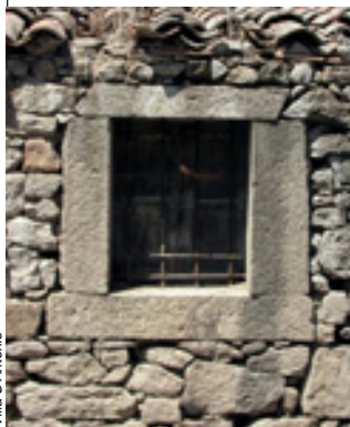
A_b 6 Finestra con stipiti e orizzontamenti in conci lapidei squadati non ammortati alla muratura, con decorazioni in rilievo
