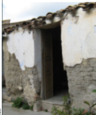
A_b 1 Porta con architrave monolitico e conci lapidei sbozzati o trovanti
