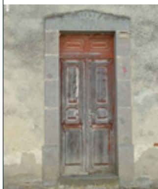
A_b 4 Porta con architrave monolitico e stipiti in conci squadati, con cornice a rilievo
