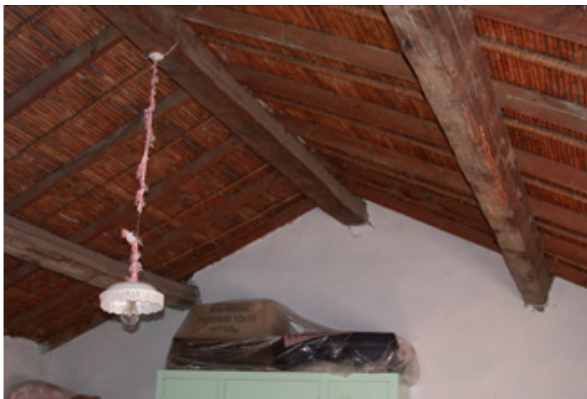
Fig. 3.24. Doppia falda con orditura doppia.
